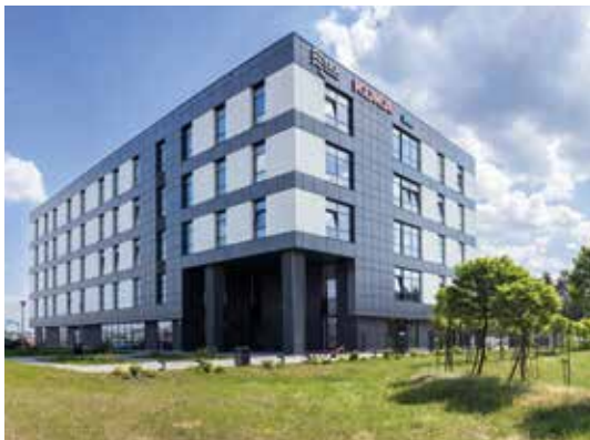
Biurowiec IDEA Przestrzeń Biznesu BPPT Bydgoszcz IDEA Business Space Office Building BITP Bydgoszcz Bydgoszcz ■ fot. BPPT
