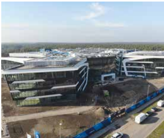
Biurowiec i centrum logistyczne NEUCA w Toruniu Office building and logistic centre NEUCA in Toruń ■ fot. CWB Toruń
